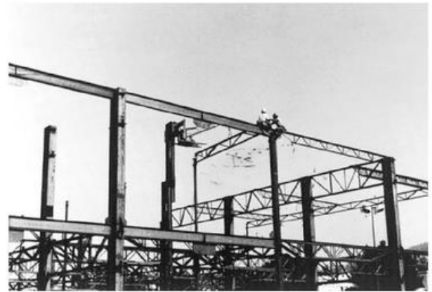
Figura 2 Montaje de viguetas de acero. [1]
