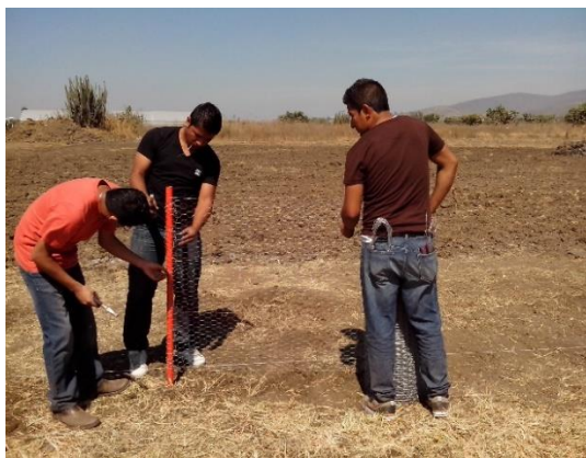
Figura 10 Colocación de soporte para cercado
