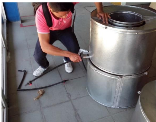
Figura 9 Colocación de líneas de dren
