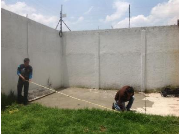
Figura 1 Área de pintura
