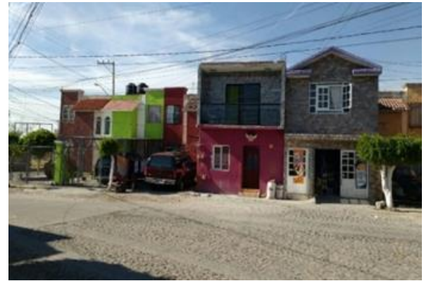
Figura 5 Parametros de la vivienda social de ambiente exterior Fuente: Elaboración propia
