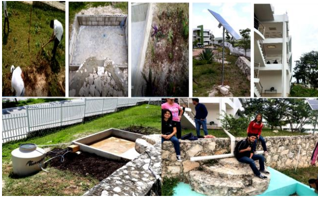
Figura 8 Construcción e implementación del sistema de captación de agua en sus diferentes etapas.
