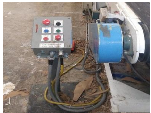
Figura 5 Instalación de Interruptor de botón momentáneo Fuente: Empresa (caso de estudio)
