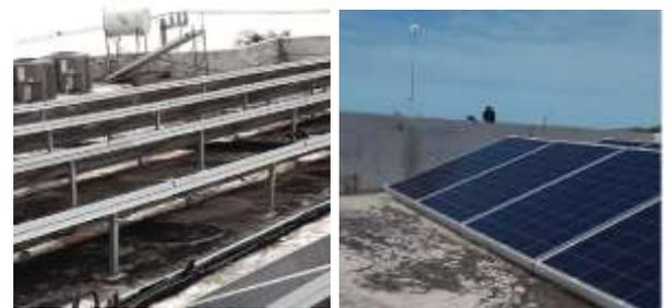
**Figura 5** Vista parcial de la planta de Generación Distribuida Fotovoltaica (GD-PV) en Campeche. Se aprecia una barda perimétrica y la nula separación de los módulos al techo, evitando el buen enfriamiento de los módulos Fuente: *Elaboración Propia*
