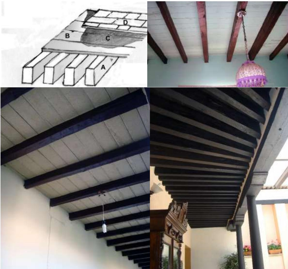
(A) Viga de madera, (B) Entablado, (C) Lodo, (D) Cuarterón de barro
