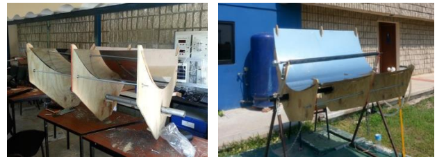
Figura 1 a) montaje de lámina en la madera, b) Concentrador parabólico cilíndrico ya terminado
