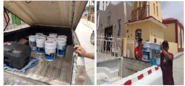
Figura 3 Apoyo de rehabilitación a Iglesia de comunidad aledaña
