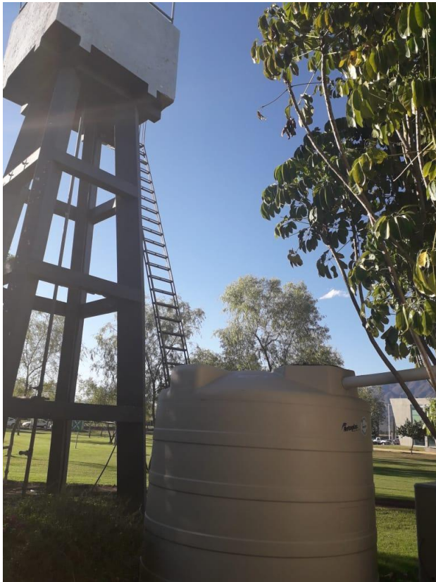
Figura 1 Sistema de captación de agua de lluvia instalado a un costado de la Rectoría del CUValles Fuente: Captado personalmente para el archivo de la presente investigación
