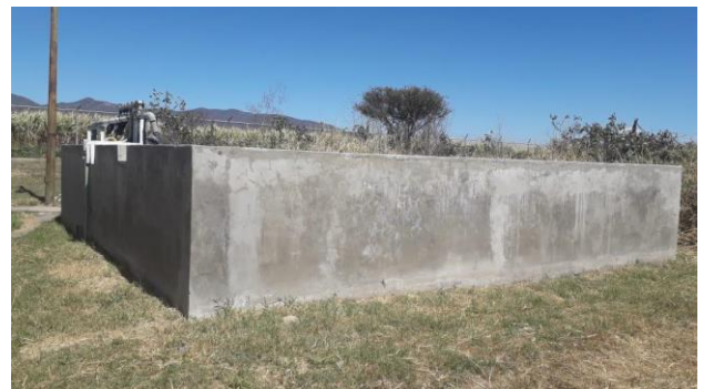
Figura 5 Infraestructura de la planta de tratamiento de agua del CUValles Fuente: Captado personalmente para el archivo de la presente investigación
